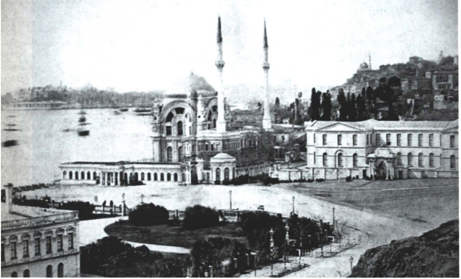
Dolmabahçe Saray Tiyatrosu, Dolmabahçe Camii'nin hemen yanındaydı. 1859'da büyük bir törenle açılmış ancak 1863'te içi tamamen yanmıştı. 1939'da stadyum projesi ve yol genişletme çalışmaları kapsamında yıkılmıştı.
