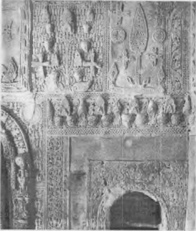
2) Aynı manastırın iç duvarından bir detay. Foto: Harry Burton. (Metropolitan
