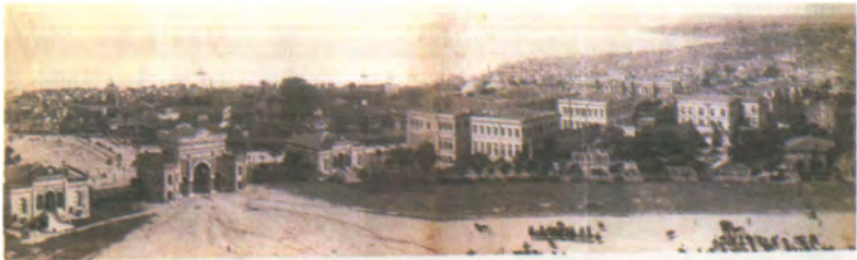
Resim II: Fuad Paşa Konağı'nın Yanında Bulunan Seraskerlik Yapılar Kompleksinin Genel Görünümü
