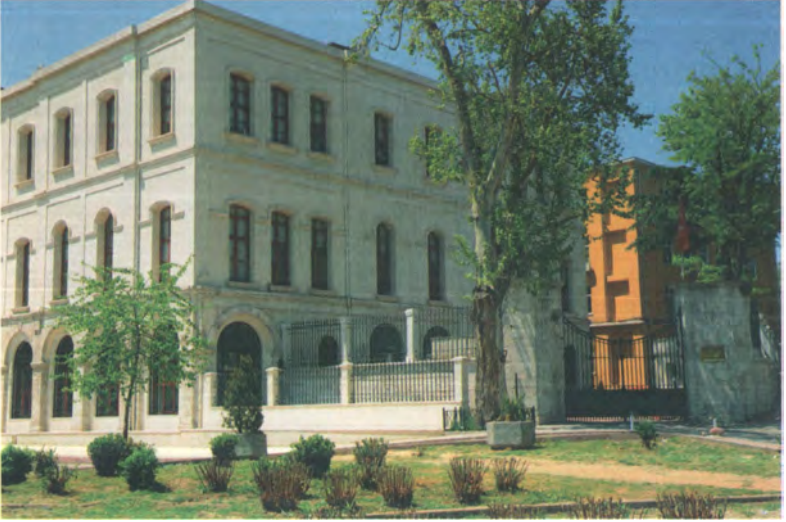
Resim IV: Günümüzde Fuad Paşa Konağı
