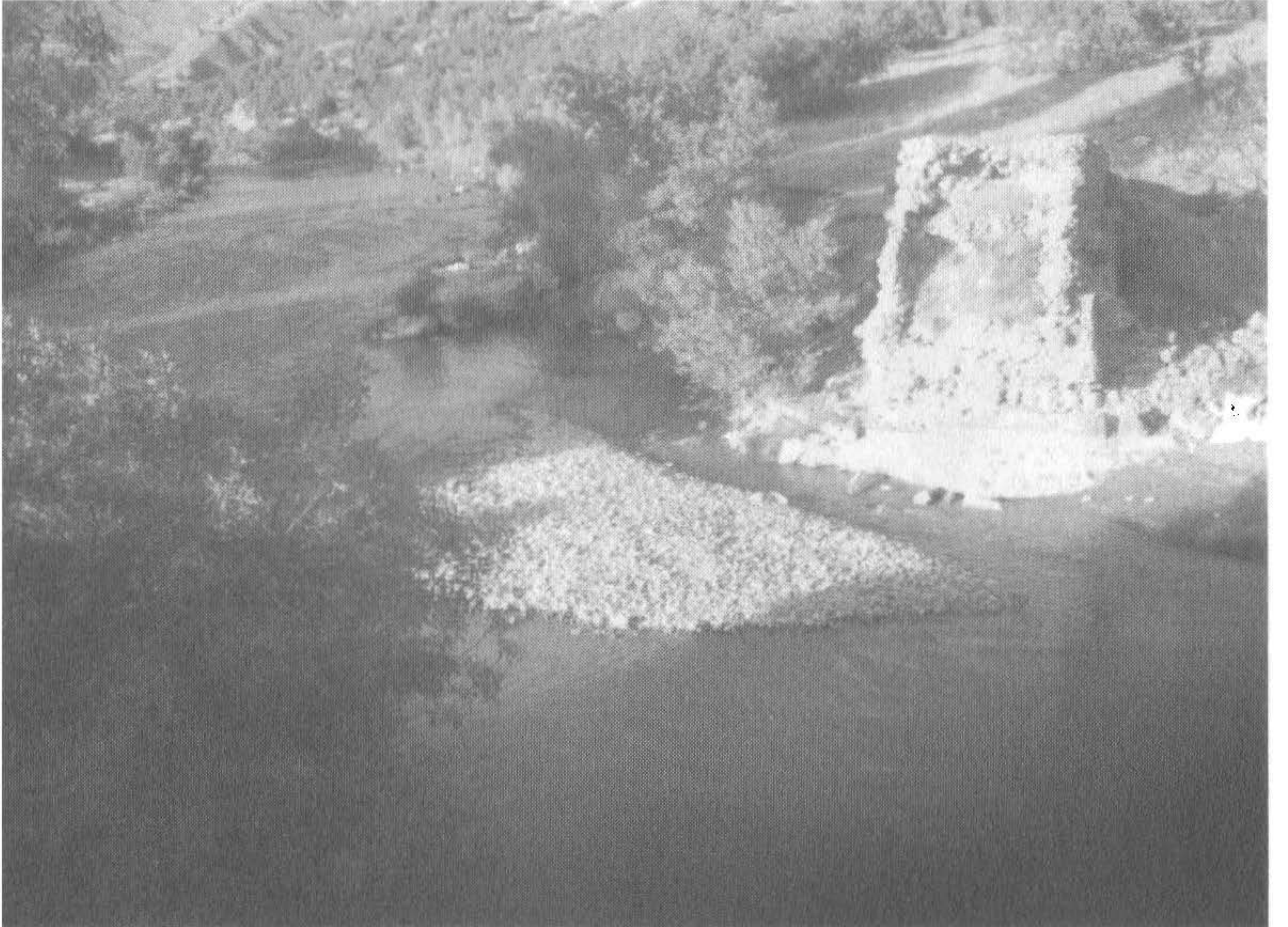
Pırde Saar: 1937'de yakılan köprü, Dersim merkez Sinan'da, askeri harekât bu köprünün yakılması gerekçesiyle başlatıldı.
