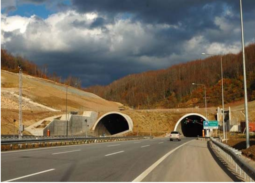
Resim 6: Tünellerin kontrol edilmesi mütecavizin taarruz ve intikallerini zorlaştırır
