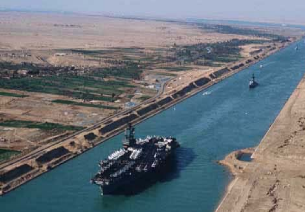
Resim 4: Kanallar kontrollü geçiş imkânı sağlar
