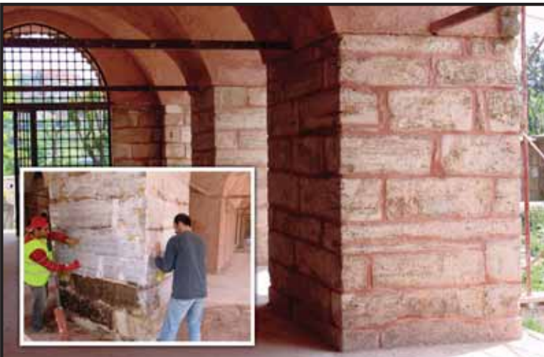
Taş kaidelere kimyasal malzemelerin yardımıyla temizlik işlemi uygulanırken.
