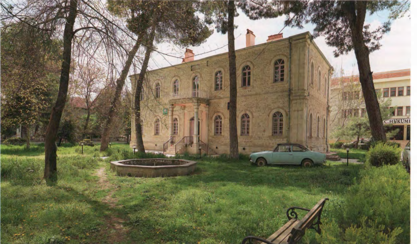
Çivril, eski Hükümet Konağı.
