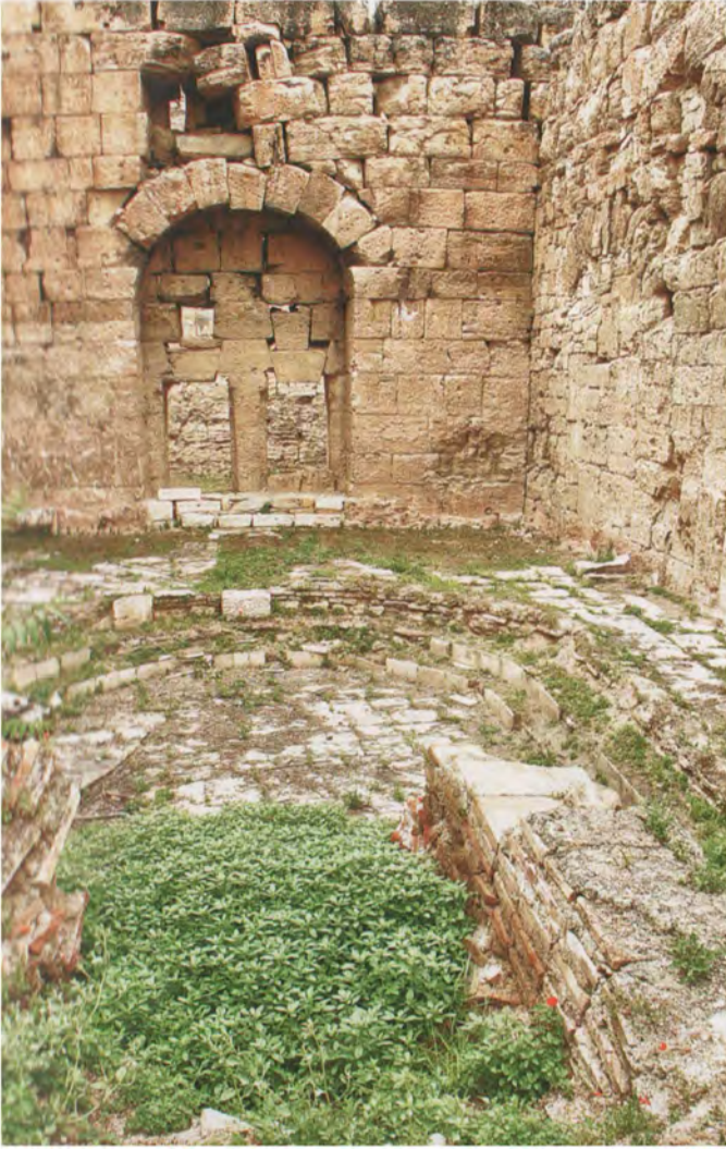
Hamam'ın havuz bölümü.
