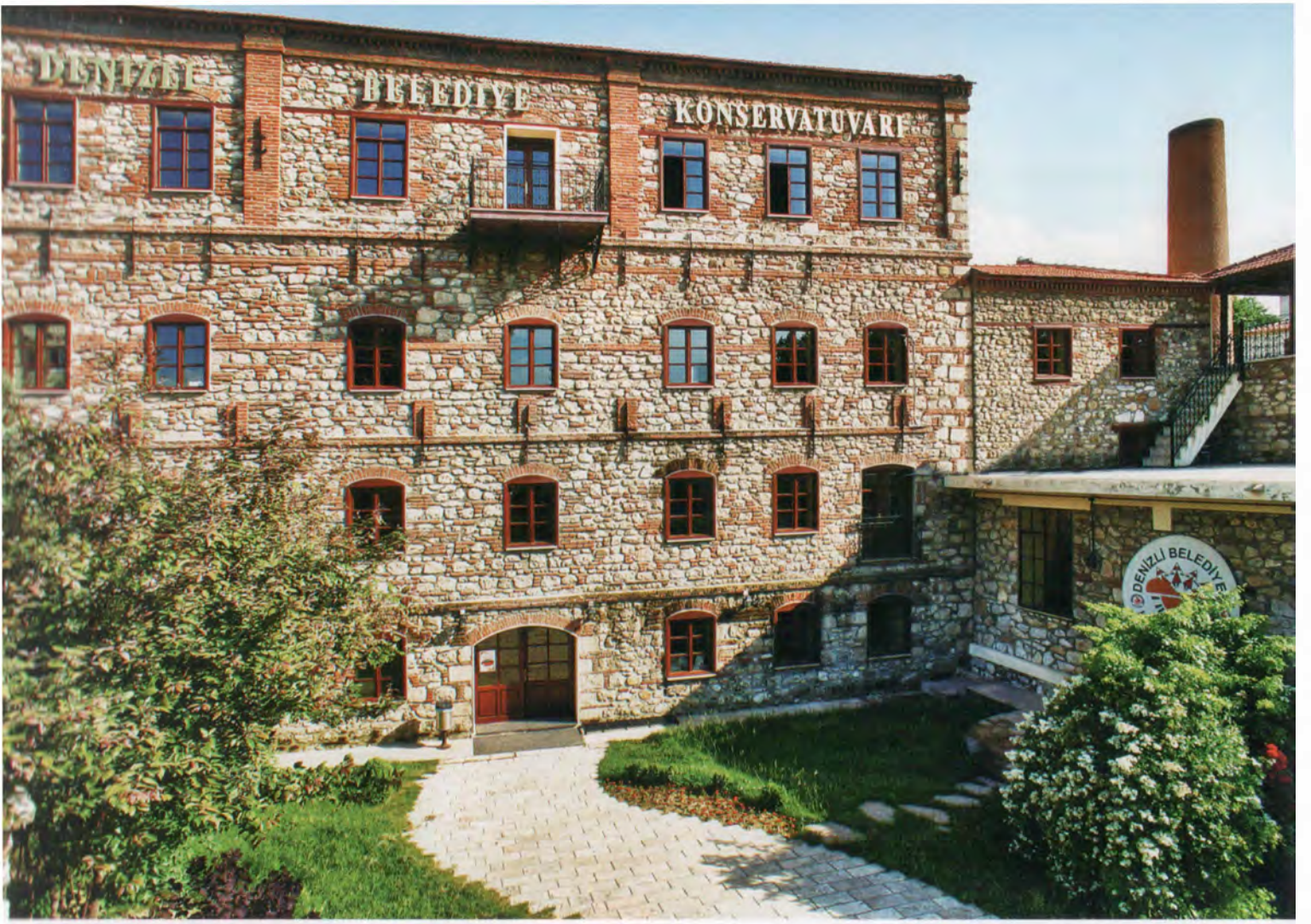
Günümüzde Konservatuvar olarak hizmet veren eski un fabrikası.
