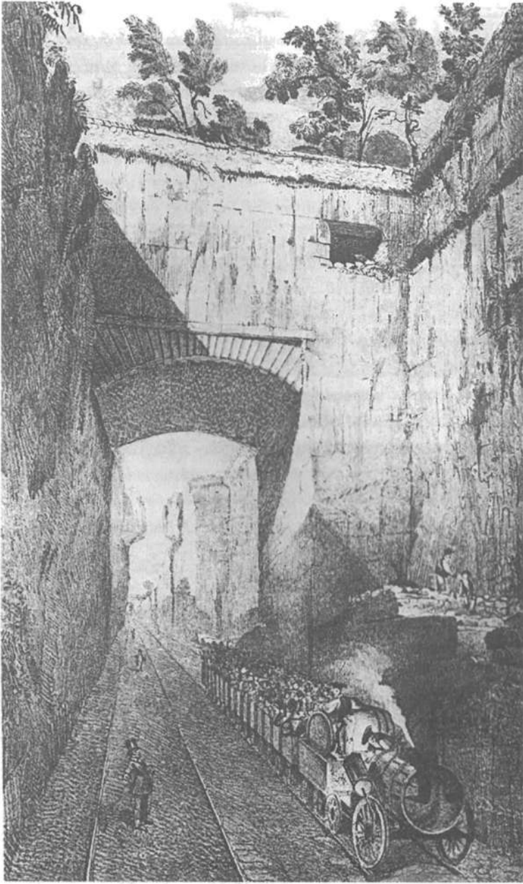
Demiryolu bölgeyi keserek geçiyor. Derin yarma ("cutting").
