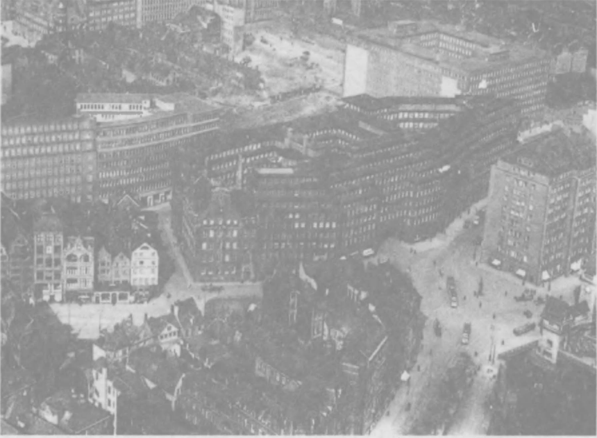
Hamburg: Operasyonlar sonucunda eski kent dokusunun yerini alan büro binaları.
