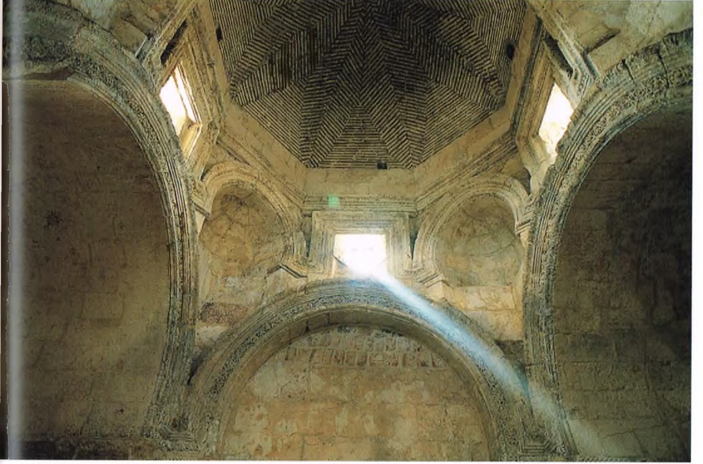
Doğrudan kesme taşların üzerine yerleştirilmiş tuğlalardan oluşan kubbe, bir dizi kemerle desteklenmiş.
