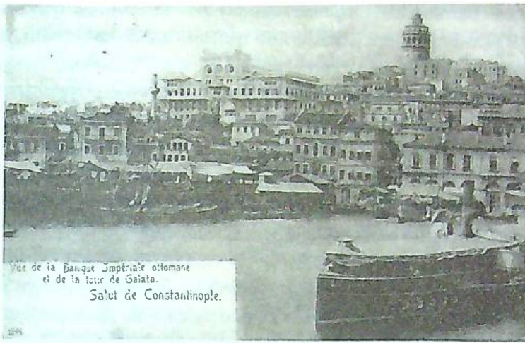
Osmanlı Bankası Binası, İstanbul Kaynak: Serdar Şalınkaya Arşivi
