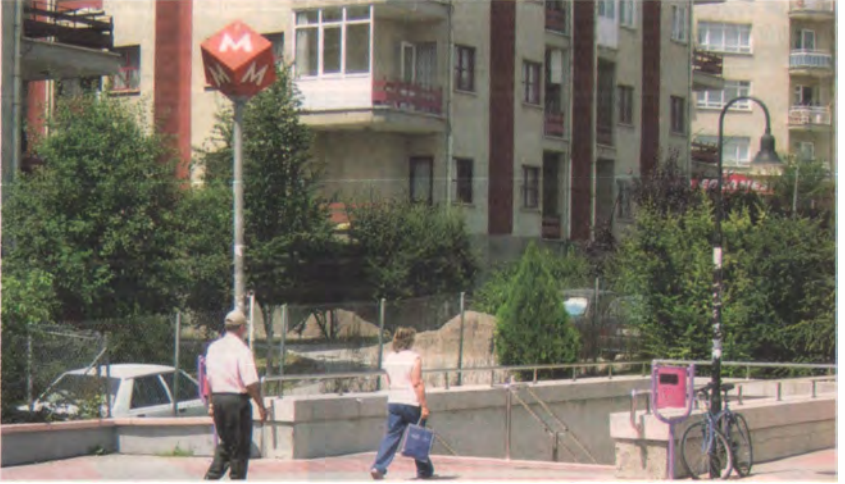
Şekil 22: Batıkent Merkezinde Metro İstasyonu Girişi. Bu denli kamusal nitelikli bir alan ile yapılar arasında bulunan tel örgüler kamusal açık alanlar ve kullanımlar ile yapılar arasındaki ilişkinin yaratılamadığını göstermektedir. Tasarımsızlık örneği bu biraraya geliş, kent merkezi ile kent merkezini çevreleyen kullanımlar ve yapılar arasındaki geçişin tasarlanmadığının ve kullanımların planlanmadığının kanıtıdır.
