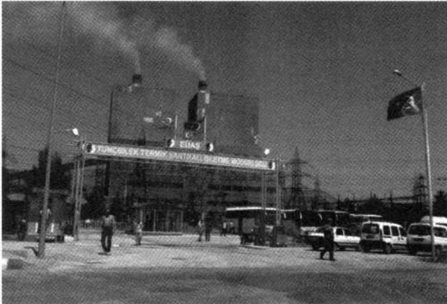
Tunçbilek Elektrik Santrali
