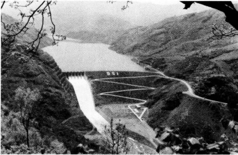
Hasan Uğurlu Barajı
