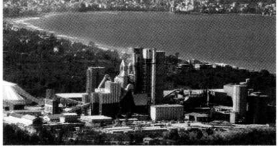
Ünye Çimento Fabrikası
