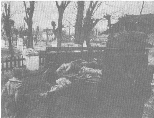
BÜYÜK ERZİNCAN DEPREMİ: 27 Aralık 1939 günü şiddetli bir deprem, Erzincan'ı yerle bir etti. Sonradan yapılan tespitler, depremin 15.600 kişinin ölümüne, 4.000 kişinin yaralanmasına yol açtığını ortaya koydu. Deprem sırasında 14.400 bina yıkıldı. En büyük zararı kent merkezi ile merkez ilçe ve köyleri gördü.
