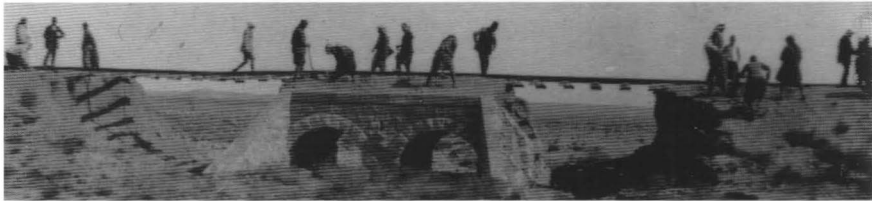
Hattı tamir eden T rkler. Sık sık    kmeler olsa da T rkler, demiryolunu Nisan 1918 tarihine kadar  alı ır tutmayı ba ardılar.
