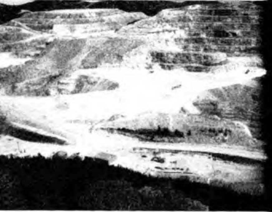
Resim 4. Düşük kalitedeki altın yataklarından yığın özütleme yöntemi ile siya- nur kullanılarak altın çıkarıldığı, bir zamanlar Amerika'nın ilk maden yatağı olan, ancak şu anda terk edilmiş durumdaki Montana'da bulunan Zortman-Lan- dusky madeni.
