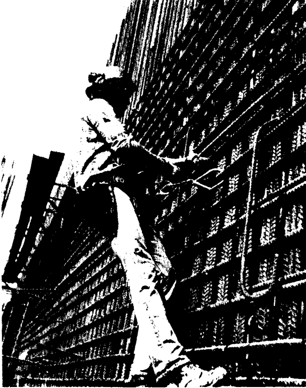
Şekil 10: Bir Westinghouse reaktörünün çelik çubukla güçlendirilmiş kuma kabuğu yapısı üzerinde bir inşaat işçisi
