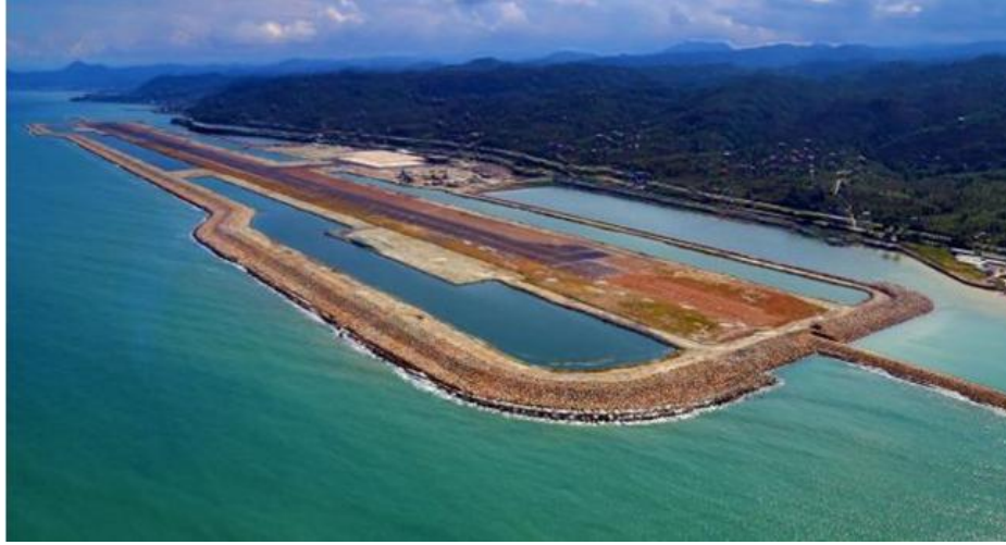
Foto: Ordu-Giresun Havalimanı inşaatı
