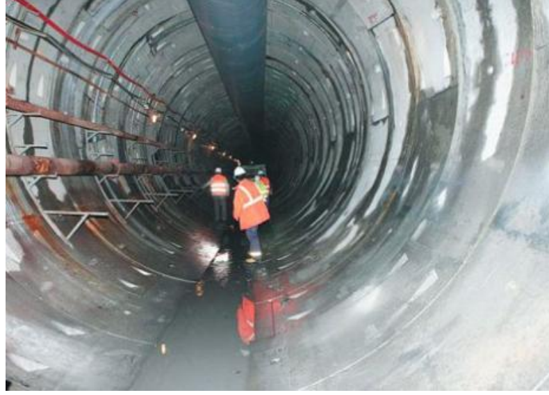
Foto: Boğaziçi Su Tüneli
