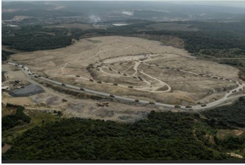
Foto: İstanbul 3.Havalimanı inşaatı
