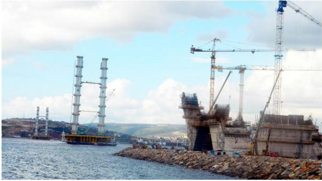
Foto: İzmit Körfez Geçiş Köprüsü inşaatı(2014)
