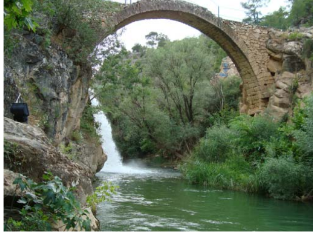
Fotoğraf: Clandras Köprüsü
