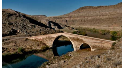
Fotoğraf: Tekgöz Köprüsü
