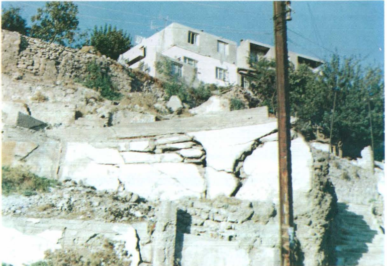
Foto 2 — İzmir-Veziraga mahallesinde yer kaymaları (heyelânlar) nedeniyle çok sayıda yıkılmış yapılar ve zarar görmüş meskenler bulunmaktadır. Fotoğraf yer kayması ile daha önce yıkılmış meskenleri ve bugün aynı tehlikeli bölgede inşa edilmiş bir binayı göstermektedir.
