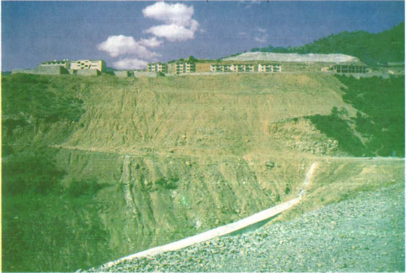
Foto 11 — Kürtün-Torul karayolu kenarında DSİ'ne ait binaların yer aldığı alanda görülen heyelan
