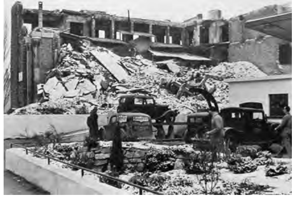
Yıl 1946; Toplumsal Arařtırmalar Enstitüsü'nün binası yerle bir...
