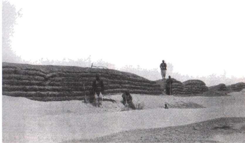
[7] Aurel Stein'in işçileri, çölde kazıp ortaya çıkardıkları Han setinin etrafında fotoğraf çektiyorlar. Setin, katmanlar halindeki dal ve kamışlardan oluşmuş tabakalı görünümüne dikkat edin.
