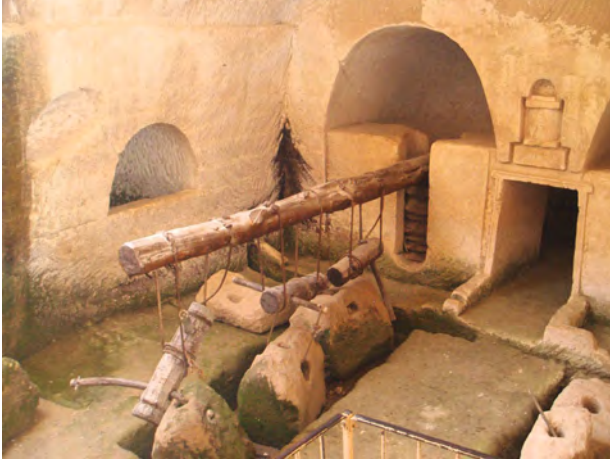
Kaldıraçlı ağırlık sistemine göre yapılmış zeytin presi (İsrail). Bu sistemin demir çağından beri kullanıldığı tahmin edilmektedir ( http://emp.byui.edu )
