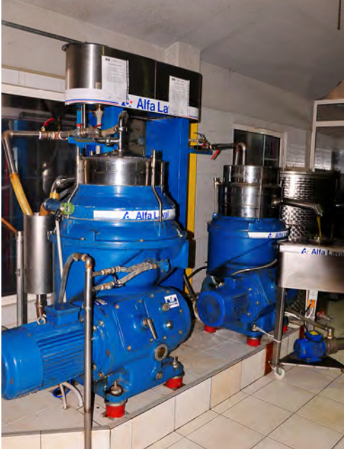
Yağ ve karasuyu ayıran seperatör.
