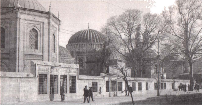
Şehzade Külliyesi'nin Divan ekseri üstündeki avlu duvarı. Resim 68. Güneydoğu duvarı ve türbeler.
