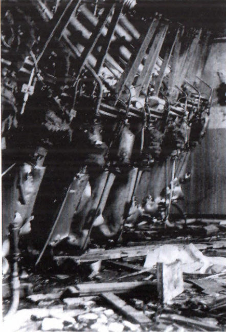
Gunnerside komando baskınında patlayıcılardan hasar görmüş ağır su hücreleri. (Norsk Sanayi İşçileri Müzesi.)
