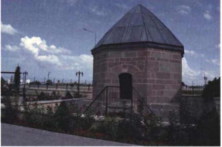
Fotoğraf 50: Ateşbaz Veli Zaviyesi'nin türbe bölümü.
