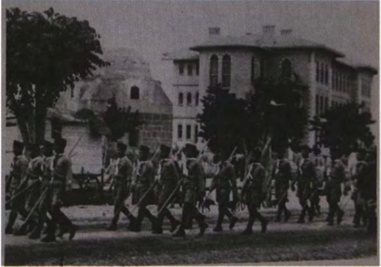
Fotoğraf 27: Anber Reis Türbesi yıkılmadan önce. Yıkamak kolay, yapmak zor!
