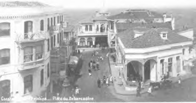
17. İskele binasının karadan görünüşü. Landward view of the pier terminal building.
