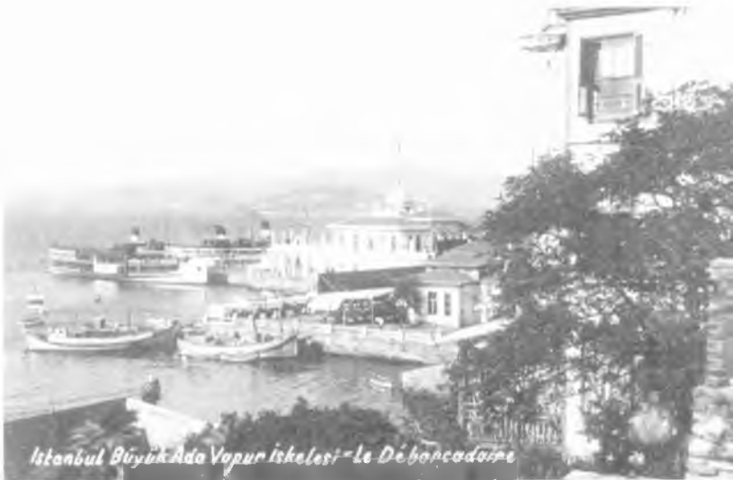
14. Büyükada iskele binası ve Şehir Hatları vapuru (1960'lar). The terminal building on Büyükada Pier and one of the Maritime Lines ferries in the 1960s.
