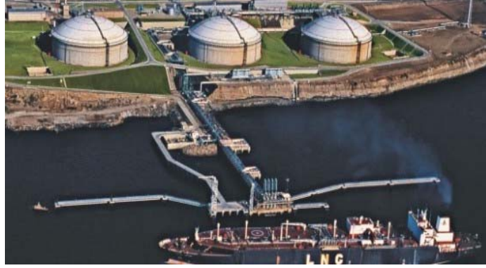
Foto: BOTAŞ Doğal Gaz Tesisleri(Marmara Ereğlisi)
