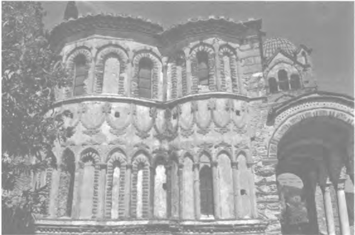
1420'lerde Mistra'da inşa edilen Pantanassa (Herkesin Kraliçesi) Manastırı. Fleur-de-lis [zambak] ile taçlandırılmış süslü çelenkleriyle Gotik unsurların bariz işaretleri bulunan kuzey cephesi.
