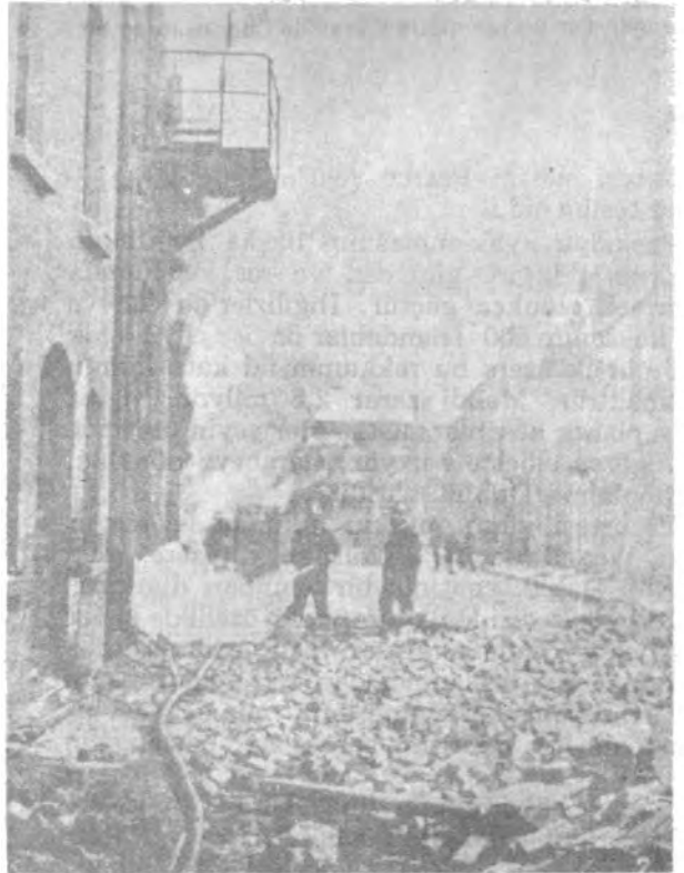
Dublindaki Otal Impareil hasar görmüş Yangın söndürme çalışmaları
