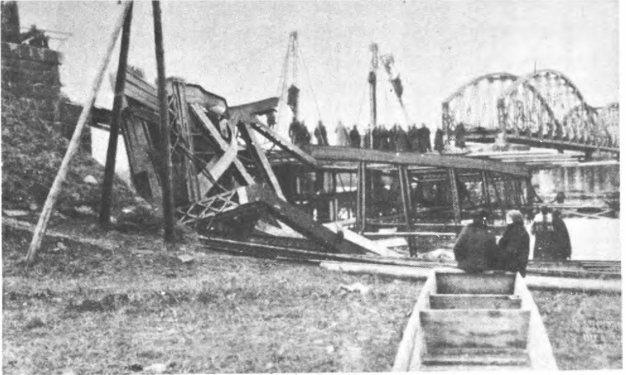
Dujanec'te havaya uçurulan önemli bir köprü.
