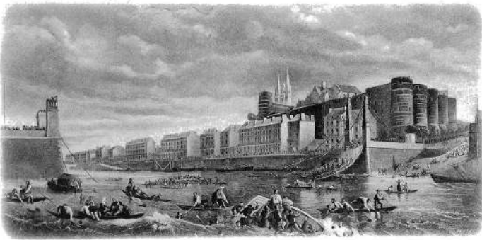
Angers Asma Köprüsü'nün çöküşü
