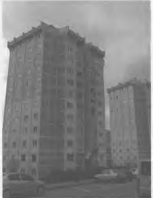
RESİM 4. Sitedeki bir apartman bloğu, 2015.
