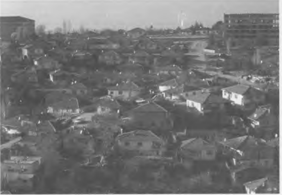
RESİM 5. Yıkılmaya direnen bir grup gecekondu, Ege Mahallesi, Mamak, 2015.
