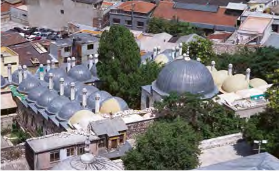
Fotoğraf 6: Salis Medresesi, horasan sıvalı tonozlar, kil sıvalı kubbeler ve kurşun kaplamalı kubbe
