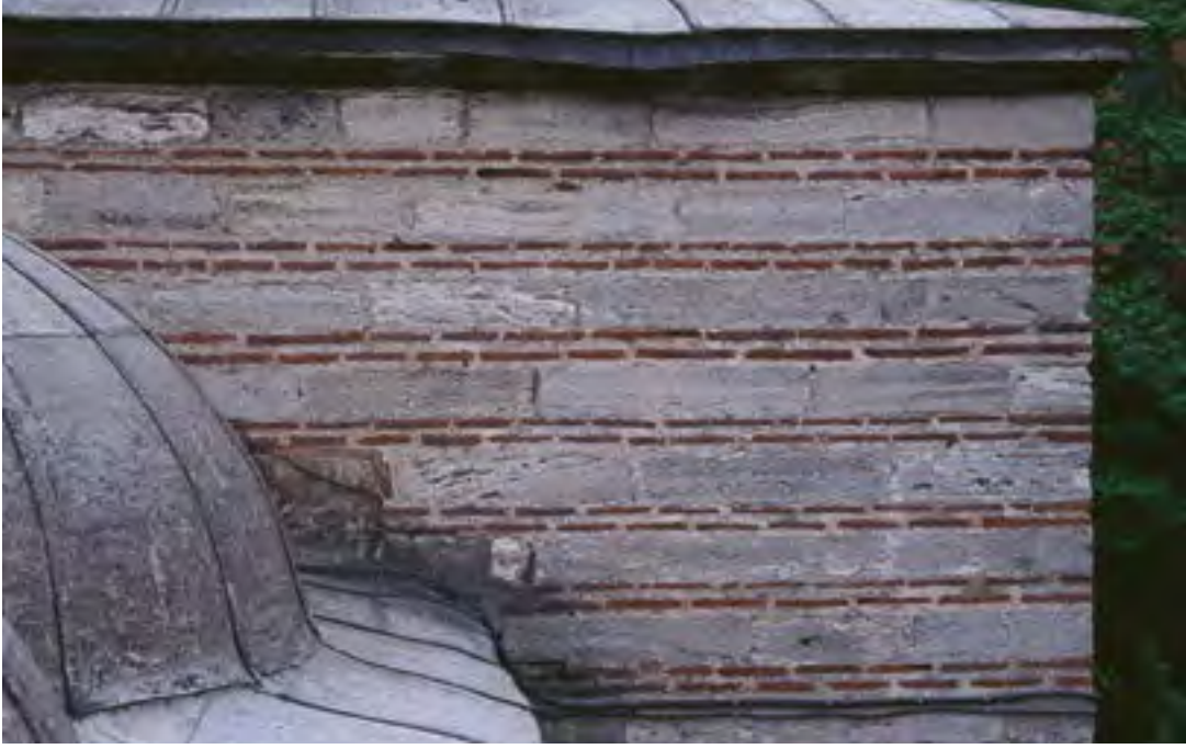
Fotoğraf 2: Evvel Medresesi, baş odası kuzey cephesi, taş/tuğla almalı duvar örgüsü
