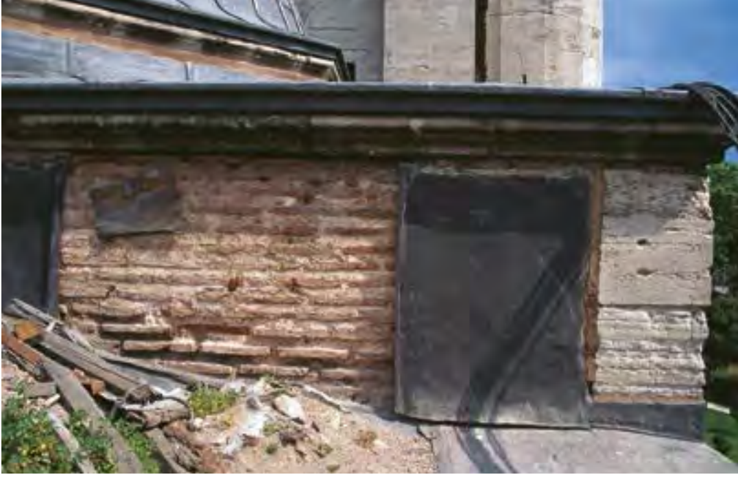
Fotoğraf 3: Süleymaniye Camii, son cemaat yeri kubbelerinin üst kısmındaki cami kuzey duvarı, tuğla örgü
