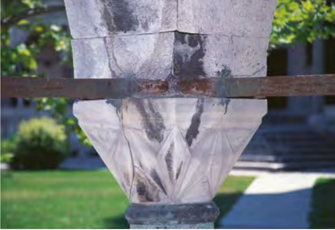
Fotoğraf 4: Süleymaniye Camii dış avlu güneydoğu kapı yapısı, kubbeyi taşıyan kemerlerin gergilerinin birleşim noktası
