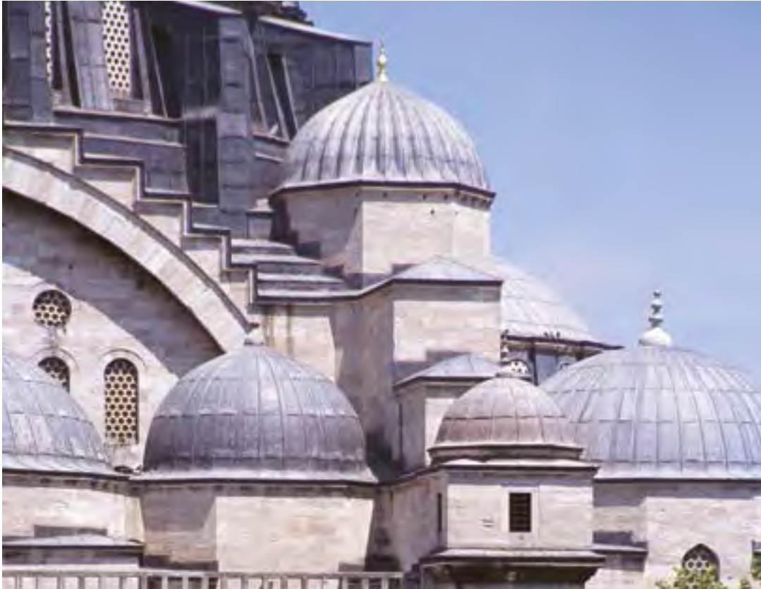
Fotoğraf 8: Ağırlık kulesi destek sistemi
