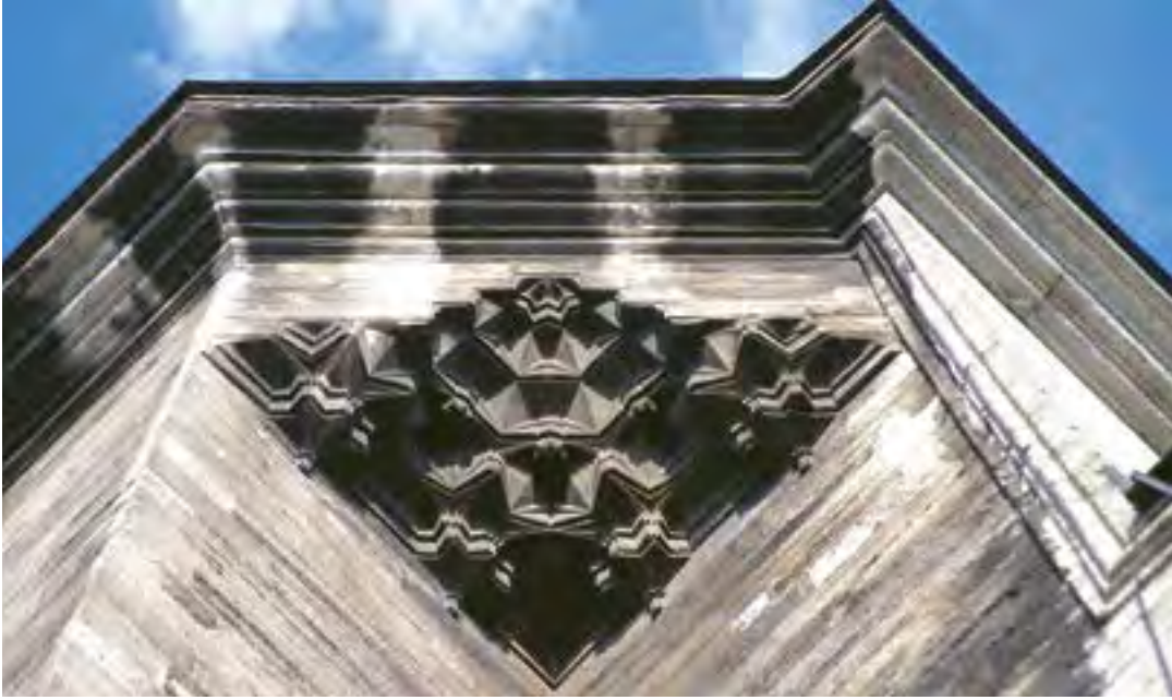
Fotoğraf 24: Güneydoğu köşe payandası mukarnaslı köşe bağlantısı
