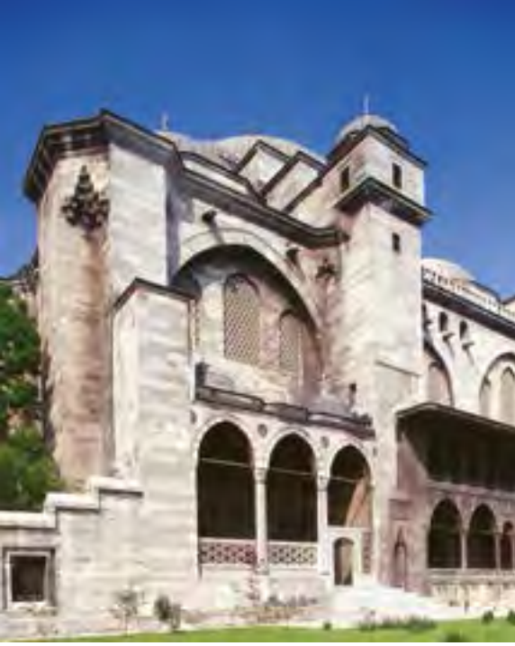
Fotoğraf 22: Güneydoğu köşesi payandaları mukarnası köşe bağlantısı ve kat silmeleri
