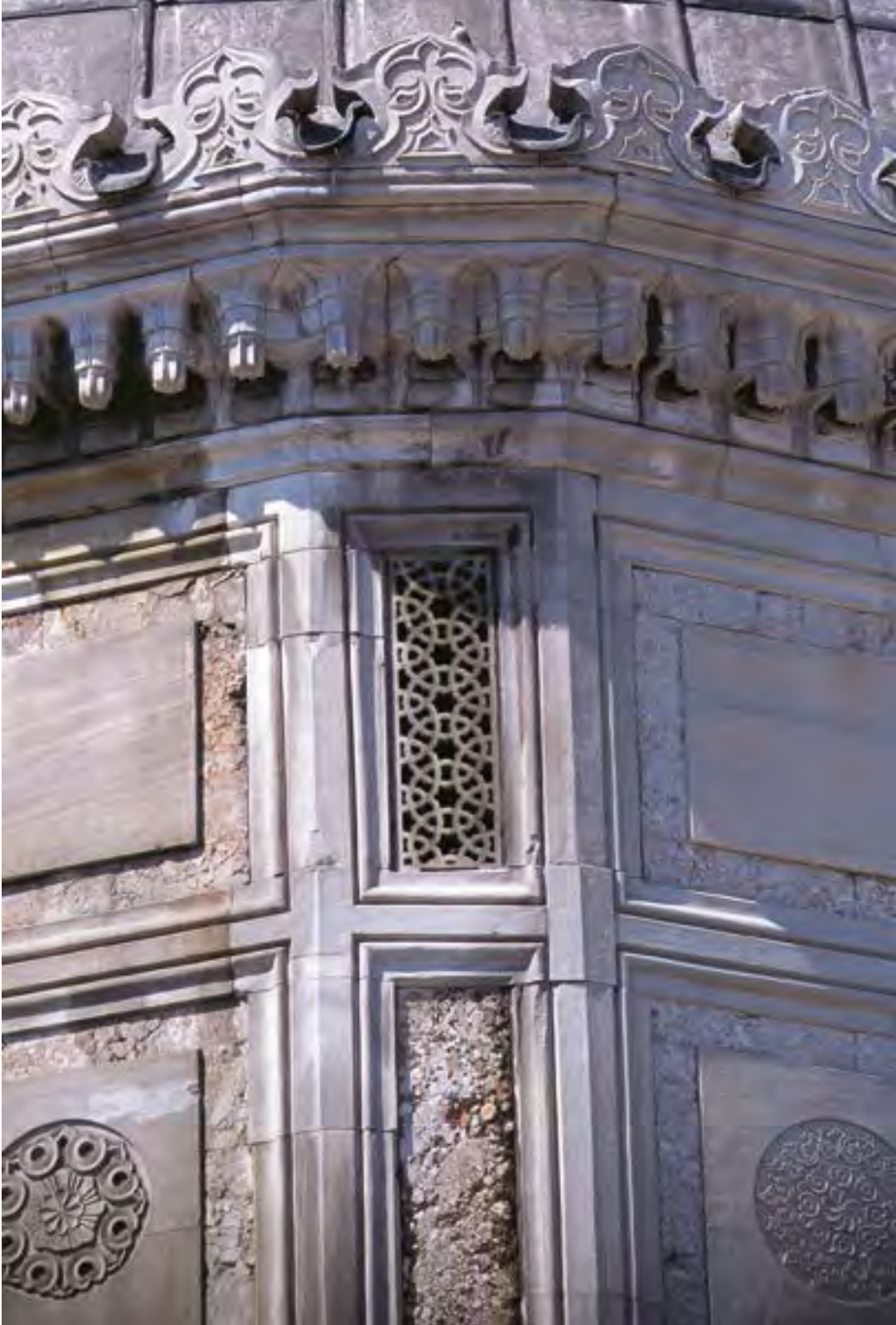
Fotoğraf 8: Kanuni Sultan Süleyman Türbesi çift cidarlı kubbe aralığını aydınlatan mermer pencere şebekesi ve türbe taç bezemeleri
