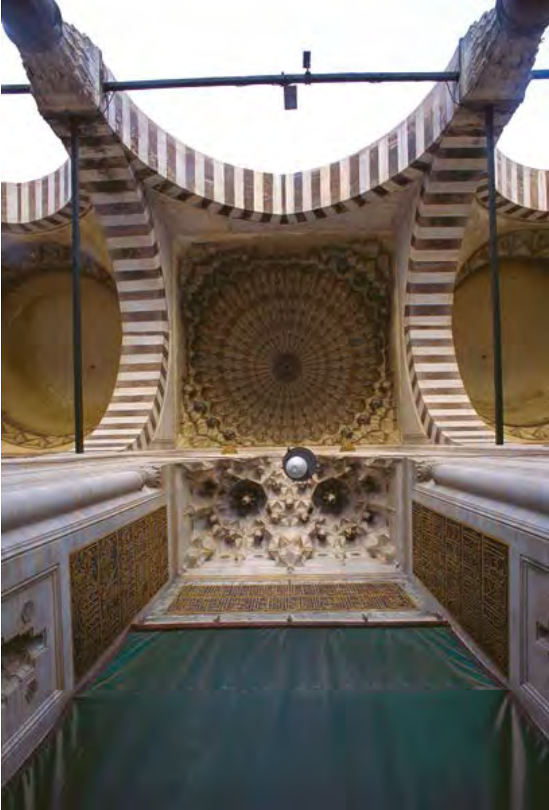
Fotoğraf 4: Harim cümlekapısı önü revak kubbesi ve mukarnas daireleri
