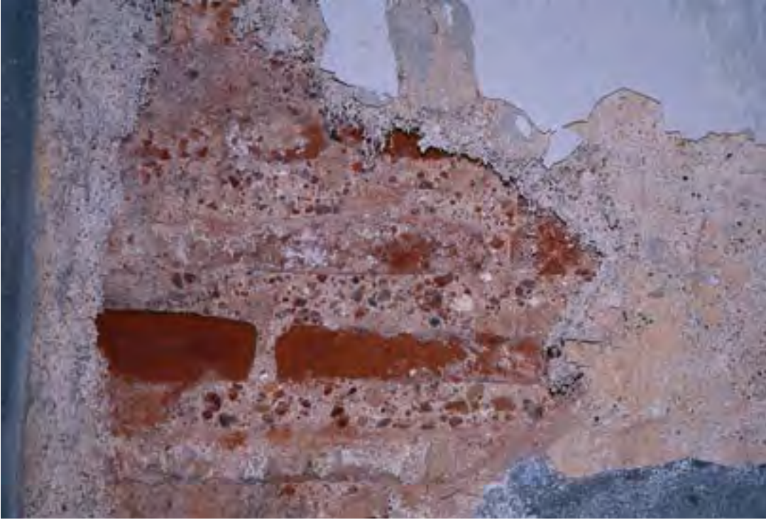
Fotoğraf 11: Bimarhane, horasan harcı
