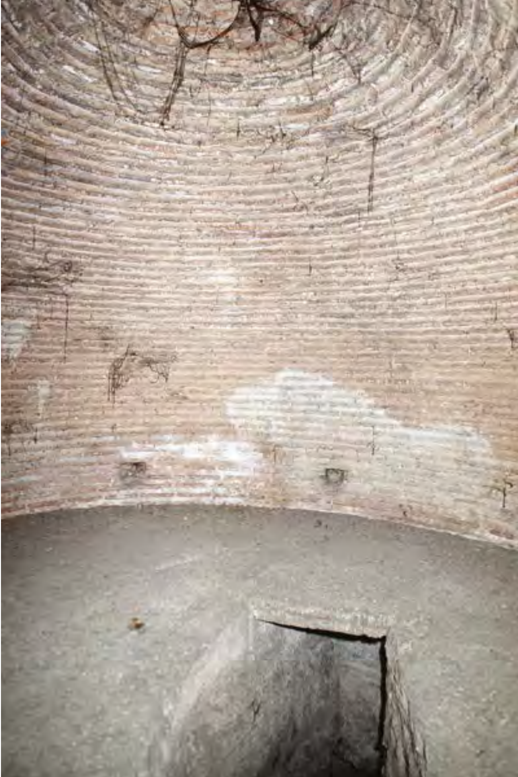
Fotoğraf 5: Süleymaniye Camii kuzeybatı ağırlık kulesi kubbesi, örgü içinde ahşap kalıbın yerleştirildiği delikler
