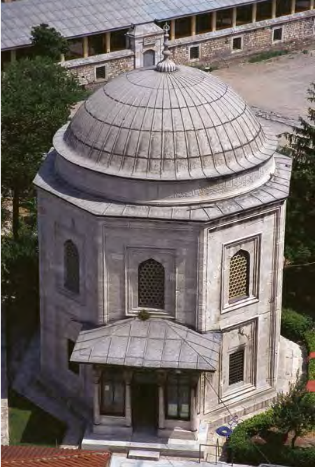
Fotoğraf 2: Haseki Hürrem Sultan Türbesi genel görünüşü
