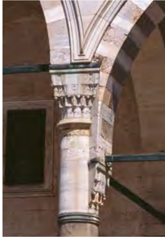
Fotoğraf 14: Revaklı avlu kemerinin kavuşma noktasında kaydırılmış sütunbaşı
