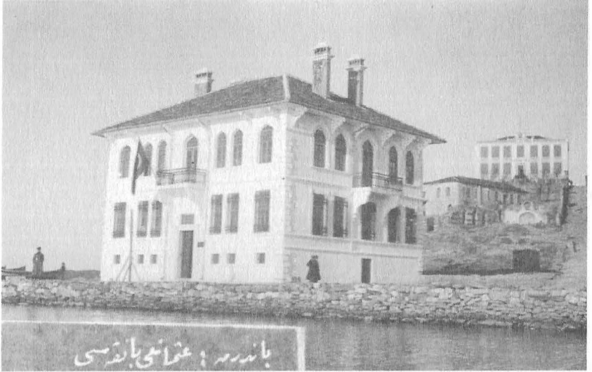
Osmanlı Bankası Bandırma Şubesi (NES Arşivi).
