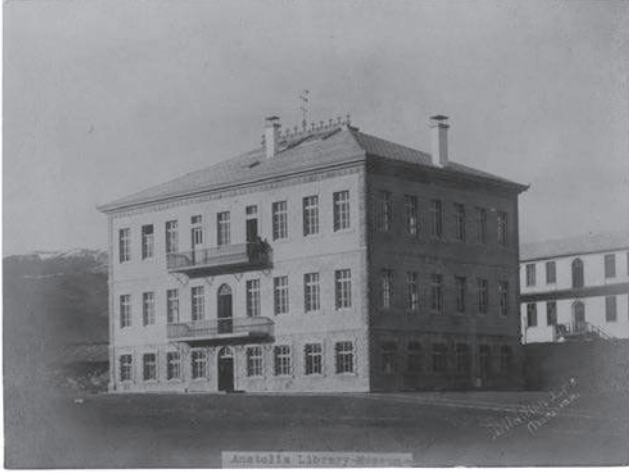
Merzifon Anadolu Koleji Müze Binası (SALT-ARIT arşivinden)
