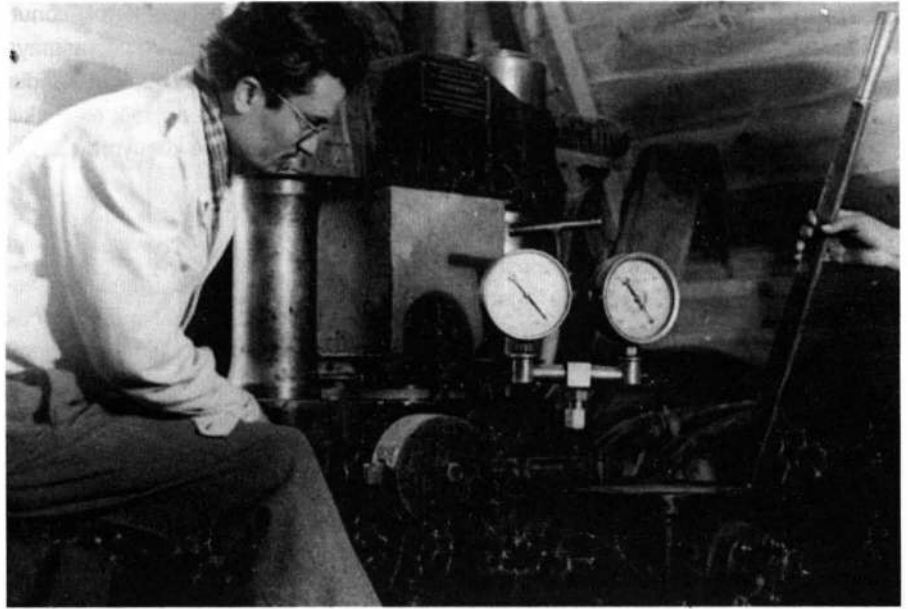
Porsuk Barajı Beton laboratuvarında basınç ve de su geçirimsizlik deneyleri ile denetim yapılmıştır.
