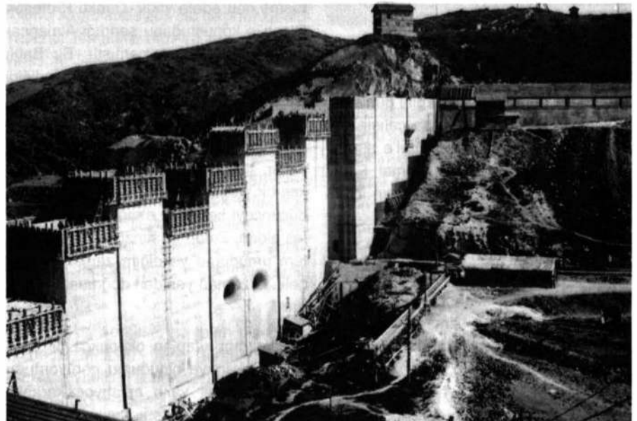
Porsuk Barajı yapımı. Yıl 1946-52.
