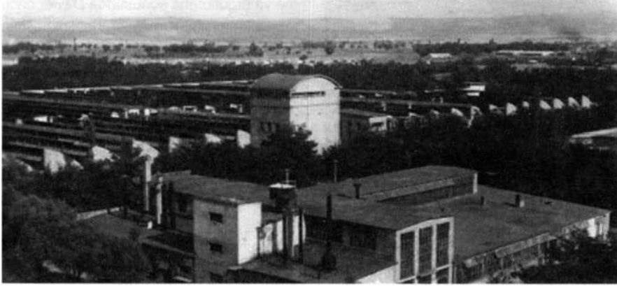
1935 tarihinde açılışı yapılan Sümerbank Kayseri Bez Fabrikası, Sanayi Planları'nın sanayi kentleri oluşturma hedefinin ilk örneklerinden birisidir. Sanayi kentlerinin yaratılması düşüncesi, kentlerin sanayi gelişmelerinin sağlanması kadar yeni kent uygulamaları olarak Sanayi Kentleri kurulmasını içermektedir.
