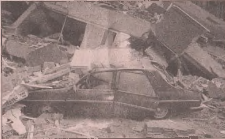
İnsanı öldüren deprem değil, depreme dayanıklı olmayan yapılardır.
