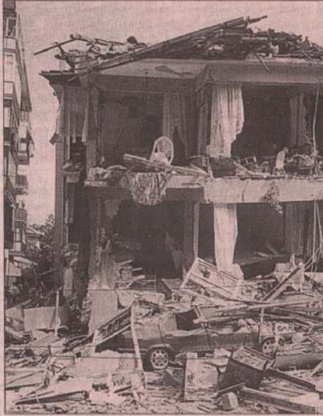
Agustos 1999 Kocaeli Depremi'nde yıkılan bir bina.
