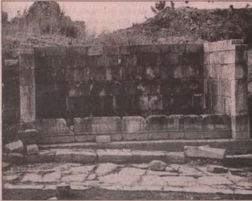
Şekil-10: Çeşme Binası.
