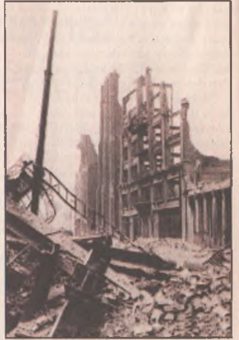
1906 San Francisco Depremi'nin yol açtığı hasar.
