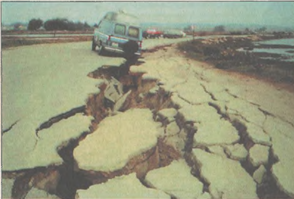
Loma Prieta Depremi'nde parçalanmış yol.
