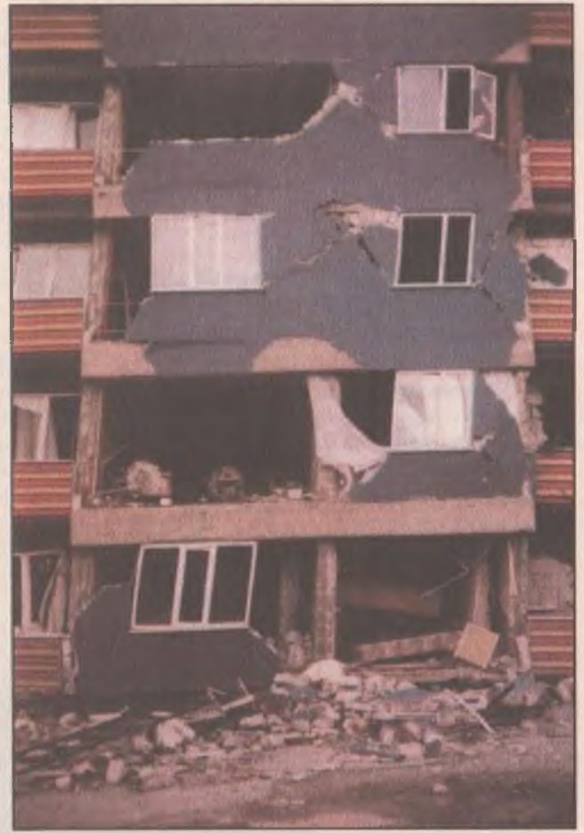
1999 İzmit Depremi'nde yıkılan bir bina.
