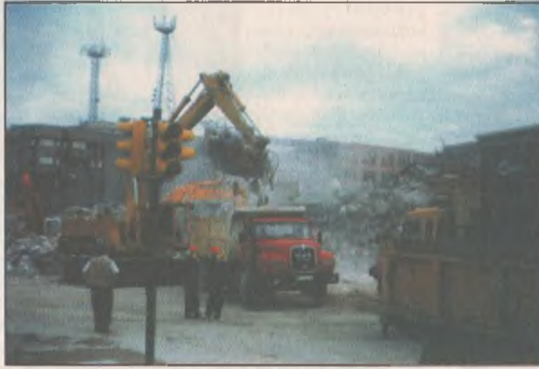
1999 Izmit depreminden sonra enkaz kaldırma çalışmaları.
