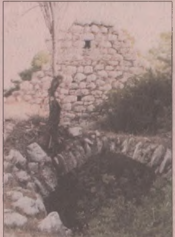
Doğucasarı'daki sur duvarı kalıntısı ve sarnıç.
