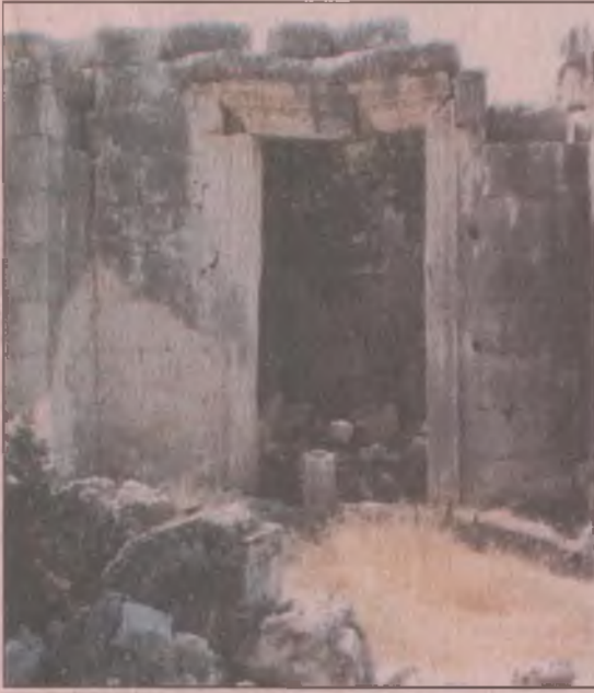
MS 2. yüzyılda yapılmış Korint Tapınağı. Kapısının üstü MS 142'deki depremde çatlamış.
