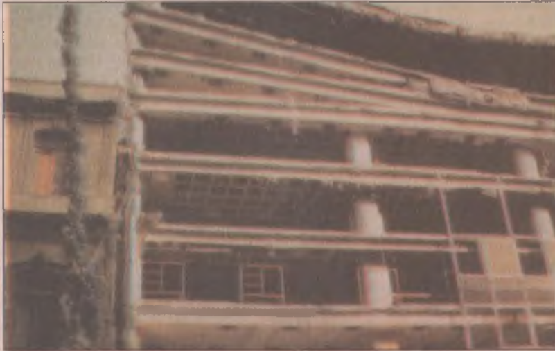
Döşeme hizasında çarpışma örneği, Meksika (19 Eylül 1985 Meksiko City Depremi, M = 8.1 )
