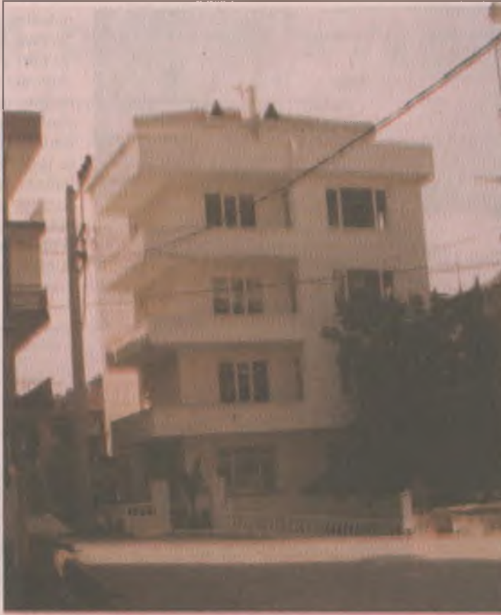
Bu bina Gölcük'tedir ve üzerinde küçük bir çatlak bile yoktur. Bu yapının çevresinde yer alan yapılarda da ancak çok az hasar görülmektedir. "Kaliteli ve sağlam binalar tesadüfen aynı yerde bir araya gelmişler" gibi bir yaklaşım doğru olmasa gerek. Durum zemin emniyeti açısından incelenmeye değer.
