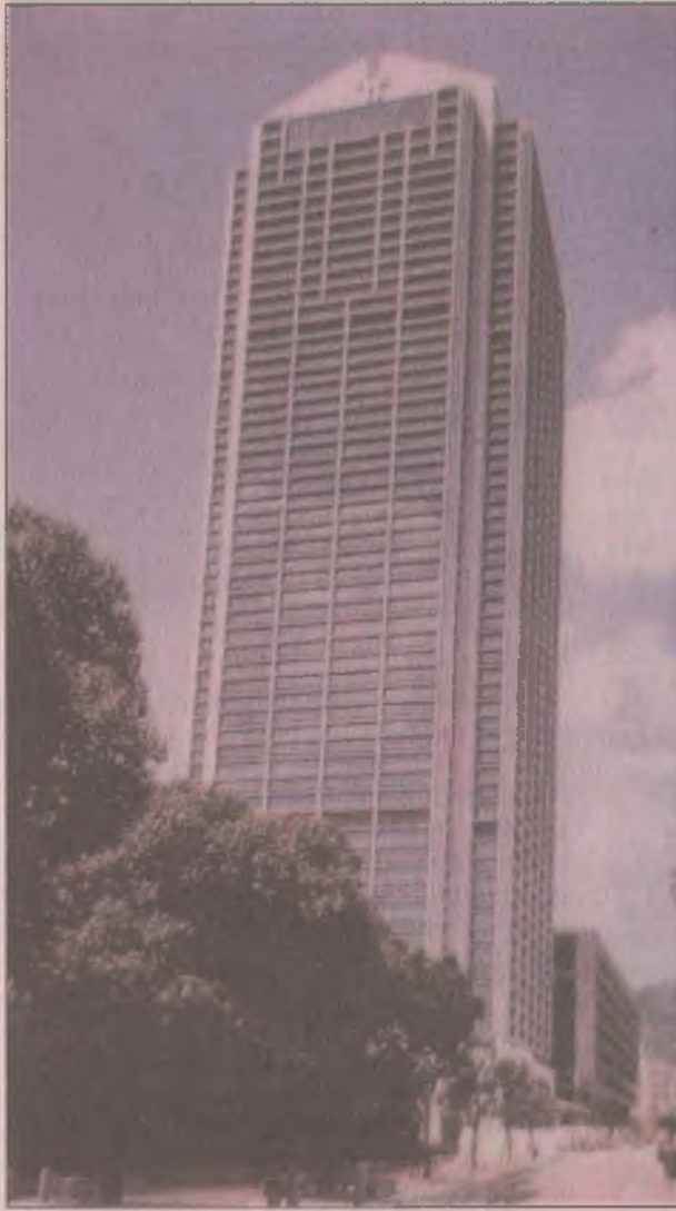
17 Ocak 1995 Kobe Depremi'nde çok hafif hasar gören belediye binası.
