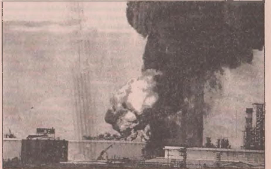
17 Ağustos depreminde en çok zarar gören kamu kuruluşumuz TÜPRAŞ.
