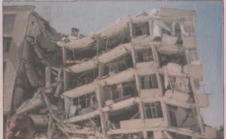
“Tehlike katı” göçmesi (27 Haziran 1998 Ceyhan Depremi, M = 6.3).
