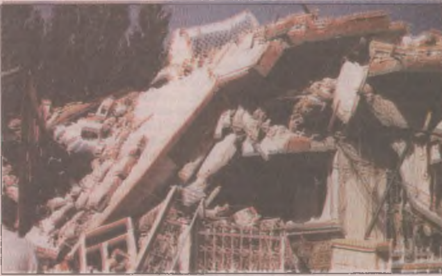
Depremde göçen bir bina
