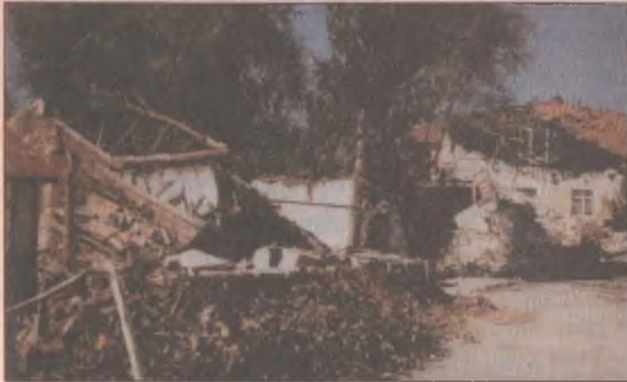
Kırsal kesimde hasarlı yapı örnekleri.
