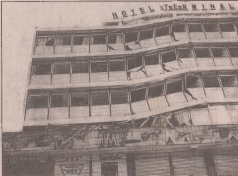
Guatemala kentindeki "Terminal Hotel" binası (4 Şubat 1976 Guatemala Depremi, M=7.9 ).
