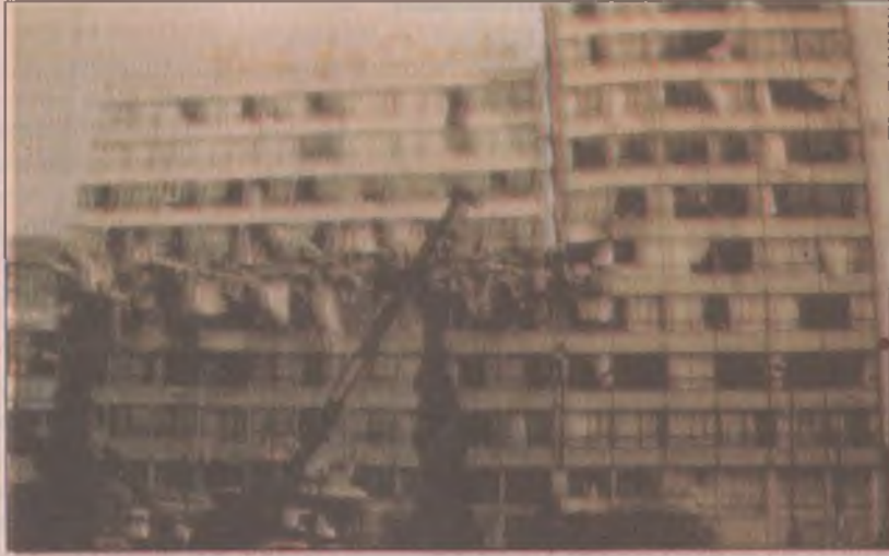
Çarpışma kurbanı Hotel de Carlo binası, Meksika (19 Eylül 1985 Meksiko City Depremi, M = 8.1 )
