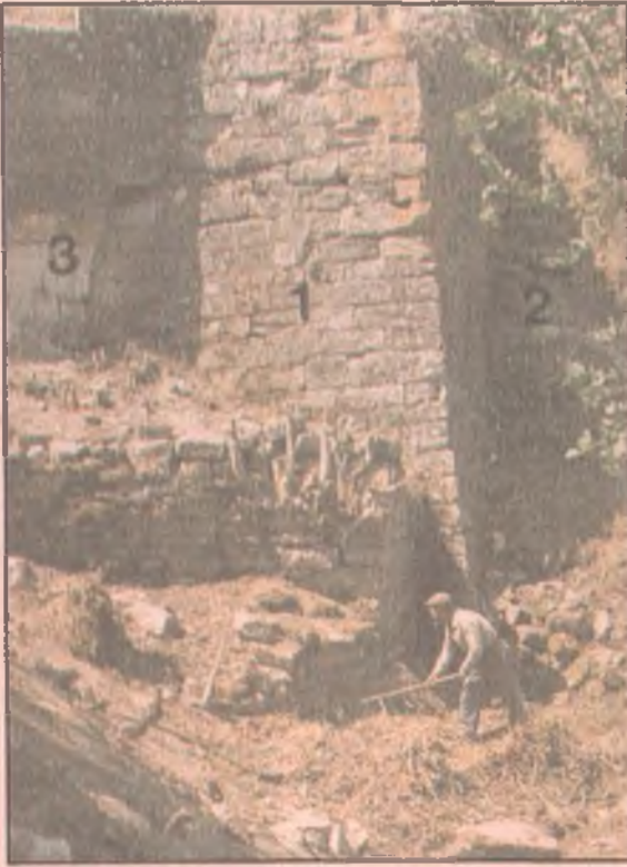
Troia VI, Kuzeydoğu bastiyonu.
