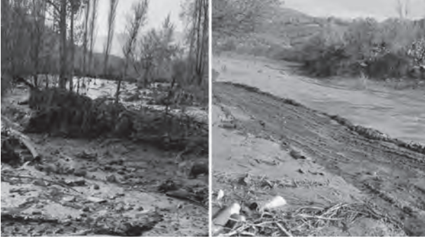
Giresun'un Şebinkarahisar ilçesinde bulunan Nesko Madencilik AŞ'ye ait kurşun-çinko-bakır madeninin atık havuzunun patlaması sonrası 4.500 tondan fazla kimyasal atık çevreye yayıldı.
