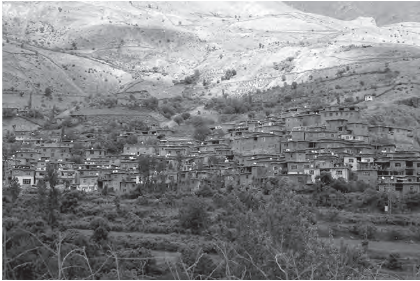
Bêdar’dan genel görünüm. Bêdar’da doğal çevreyle uyumlu biçimde geleneksel yapı yapma yöntemleriyle inşa edilmiş yoğunlukla iki katlı, kerpiç damlı, yığma taş evler görmek mümkündür.
