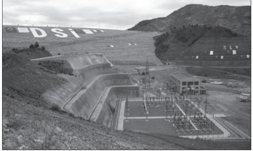
Biliminsanları Akköprü barajında (Muğla-Dalaman) uyguladıkları farklı senaryo depremleriyle yaptıkları analizlerde barajın şekil bozulma artış oranlarının ivme değerindeki artış oranından büyük olduğunu gözlemlemişler.
