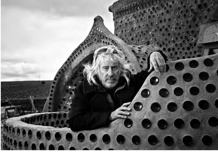
Earthship'in yaratıcısı mimar Michael Reynolds, atık cam şişelerin diplerini de duvar yapımında kullanıyor.
