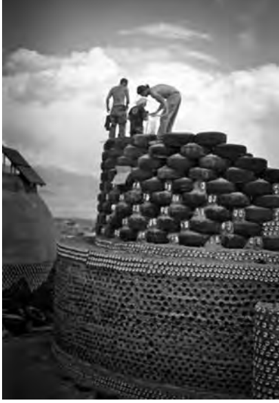
Bir Earthship yapım aşamasından. Earthship duvar yapımında kullanılan ana malzemelerden biri de atık otomobil lastikleri.
