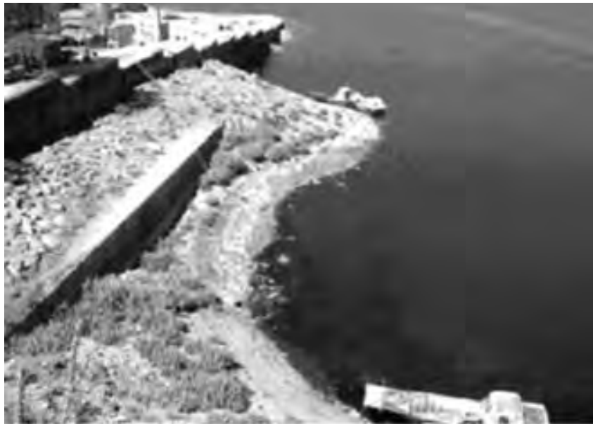
Şekil 5. "..... Geçen yıl iskelenin en üstündeki demire bağlanarak araçları alan feribot, bu yıl su seviyesinin 5 metre düşmesi nedeniyle iskelenin en altındaki demirlere bağlanmak zorunda kaldı. Atatürk Baraj göletindeki kuraklığın etkisiyle baraj gölü içerisinde yeni adacıklar ortaya çıkardı. Daha önce sadece yarım metre su üstünde olan adacıklar da bu yıl ortaya çıktı. Devlet Su İşleri (DSİ) yetkilileri, baraj göletindeki su seviyesinin geçen yıla oranla 5 metre düştüğünü doğrulayarak, başta kuraklık olmak üzere enerji üretiminin yapılması ve sulama için suyun bırakılmasının da su seviyesinin düşmesinde etkili olduğunu kaydetti " (Kaynak: DHA-AA ve Radikal / 08.09.2008)
