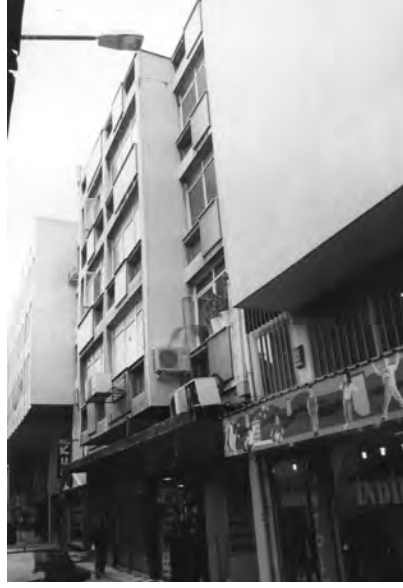
Tadilatı yapılacak betonarme yapının, önündeki dar sokaktan görünüşü.
