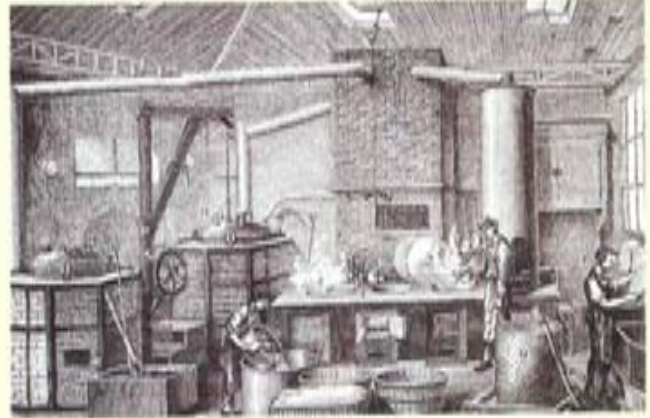
Appert, atölyesinde yaptığı deneylerde benmari düzeneğini kullanarak kavanozları 100 °C'ye kadar ısıtıyordu.
